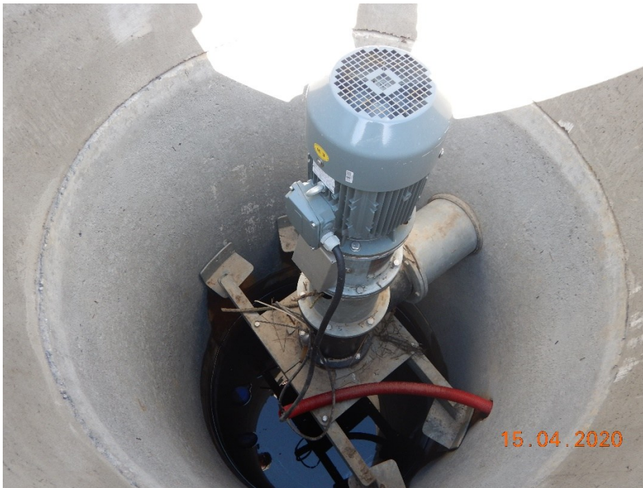
Figur 4.5 Vandet kan også pumpes ind i minivådområdet. Bemærk at der ikke ydes pumpetilskud hvis drænoplanet er under 50 ha.
