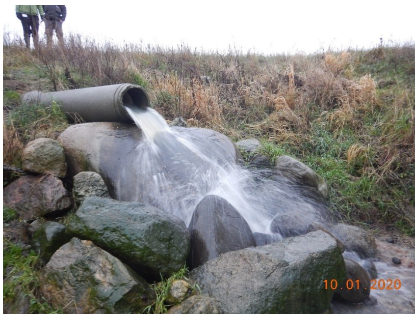
Figur 7.27 Effektiv iltningstrappe.
