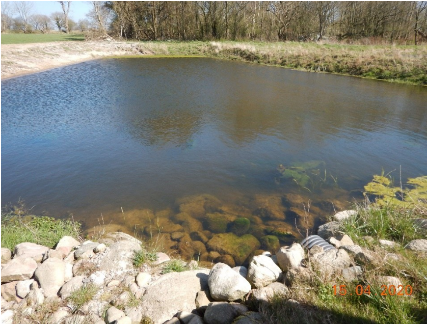
Figur 4.6 Sedimentationsbassinet opsamlar sediment og bundfælder fosfor.
