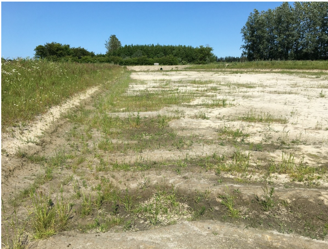
Figur 4.13 Minivådområdets bund (uden lermembran) før vandpåfyldning.
