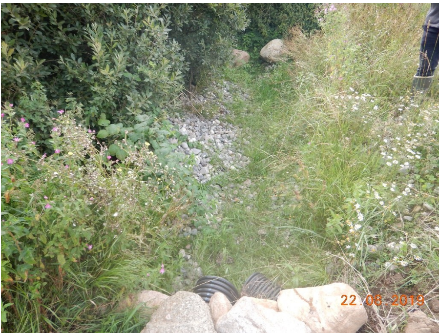
Figur 4.12 Iltningstrapper. Iltningstrapper kan se forskellige ud, som de to eksempler her viser. Vandet skal iltes før det ledes ud i vandsystemet (recipienten).
