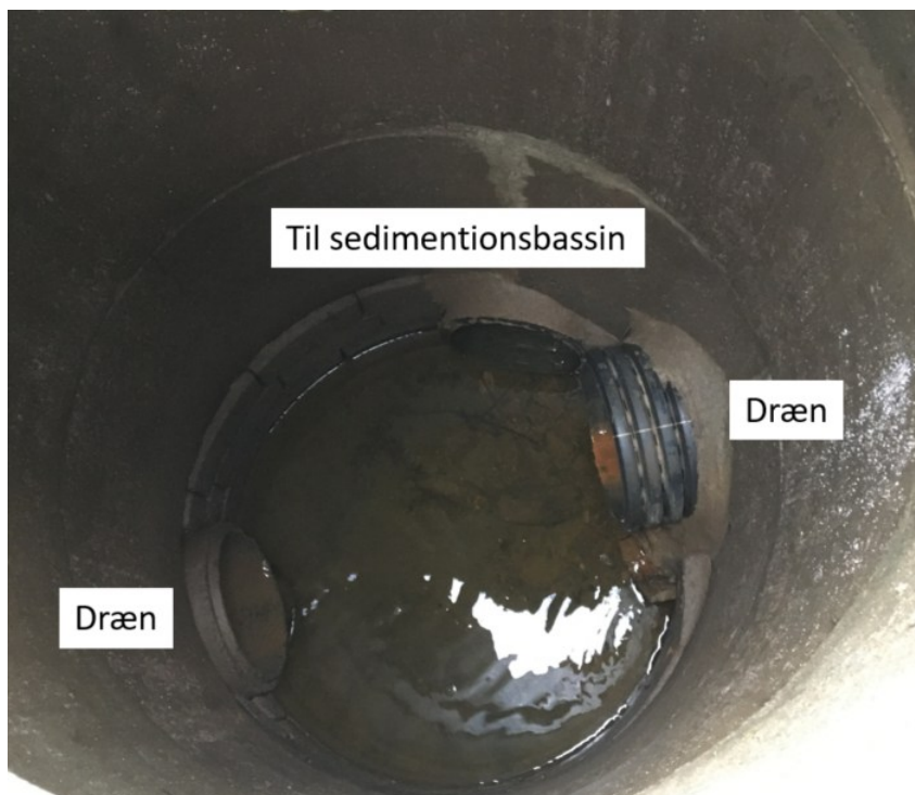
Figur 4.2 Drænrørene samles i en samlebrønd inden sedimentationsbassinet
